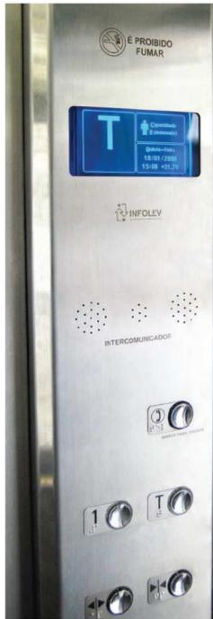
Indicador de Posição Digital - IPD em LCD informa a capacidade de carga, em manutenção, porta aberta e avisos aleatórios
